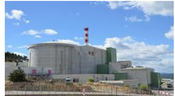
Installation Nucléaire de Base
