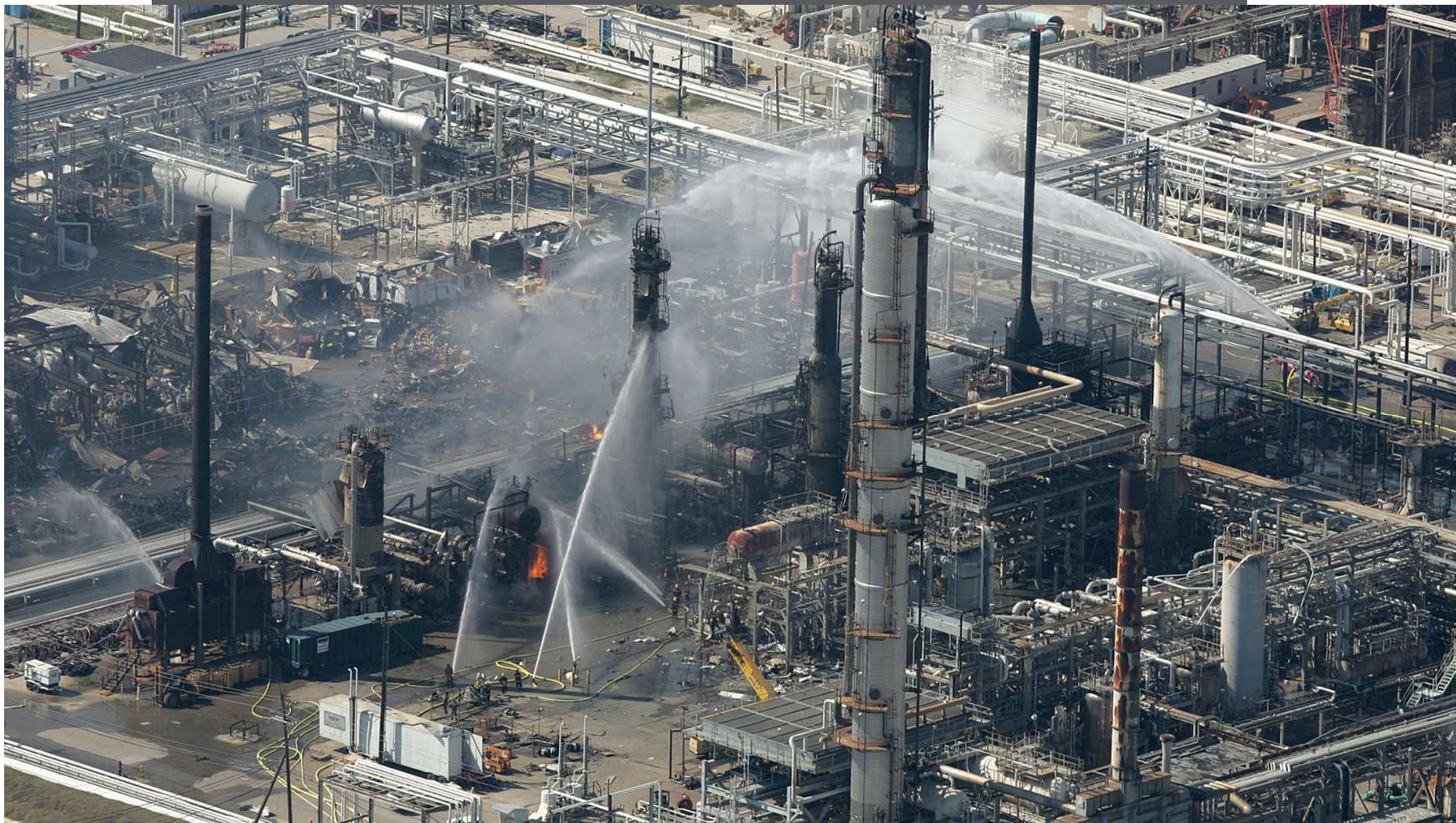
Explosion (UVCE) suivie d'un incendie éteint au bout de 3 heures
