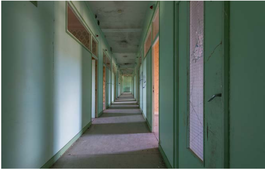
Image 6 : Couloir des chambres
