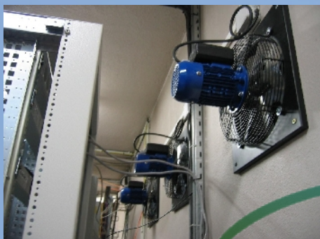
Photographie du système d'extraction prise depuis l'intérieur de la salle serveurs (Juillet 2009)
